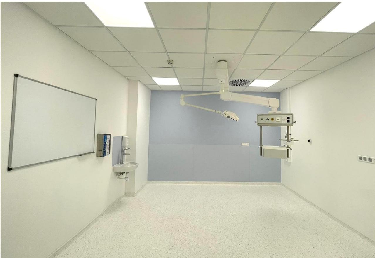
**L'un des deux box de prise en charge des urgences vitales muni d'un bras de distribution des fluides et d'un scialytique**
