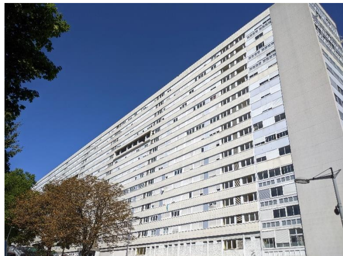
Barre d'immeuble 110 dans le quartier de la Duchère (Lyon 9 e )
